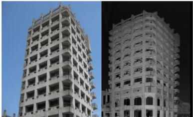
レーザ機器により取得した点群データ (右)
