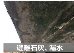
ひび割れ、断面欠損
