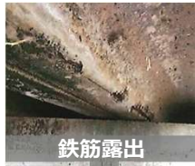
ひび割れ、断面欠損
