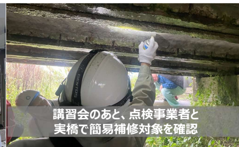
小規模橋梁点検講習会で 錆止め塗料を使用した簡易補修の説明
