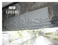
鉄筋の防錆処理
