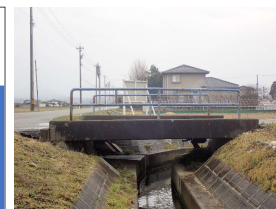
短支間RC橋の例 橋長4.8m、幅員6.6m
