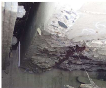
橋梁Aの損傷画像 (剥離、鉄筋露出)
