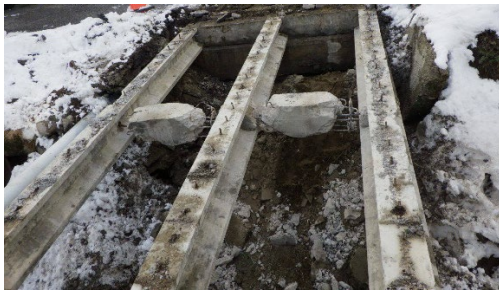
床版撤去後の状況
