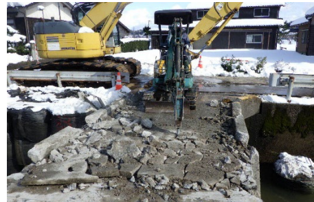
床版撤去作業の状況
