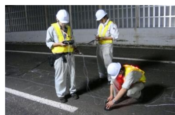
図-2 打音法調査状況
