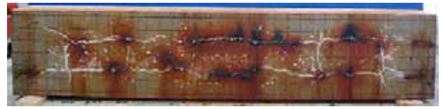
写真-5 外観状況 D16全No.2 (40A・day)
