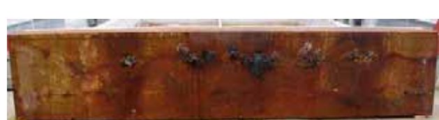
写真-6 外観状況 D16全No.2 (120A・day)
