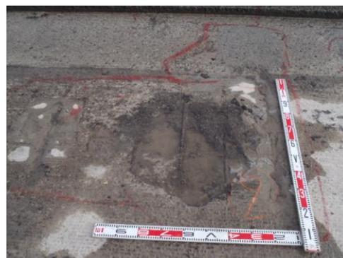
写真-1 床版劣化損傷の例
